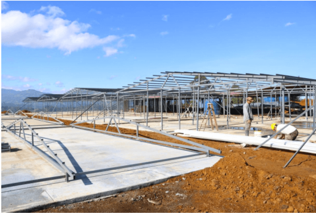
Trabajos en el campamento San Antonio de la Zona Veredal de Caldon, en Cauca. Foto: Farc.
